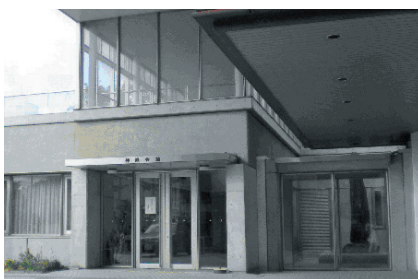
保健管理センター楠分室
